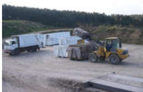
◆ Location et enlèvement de bennes à déchets
